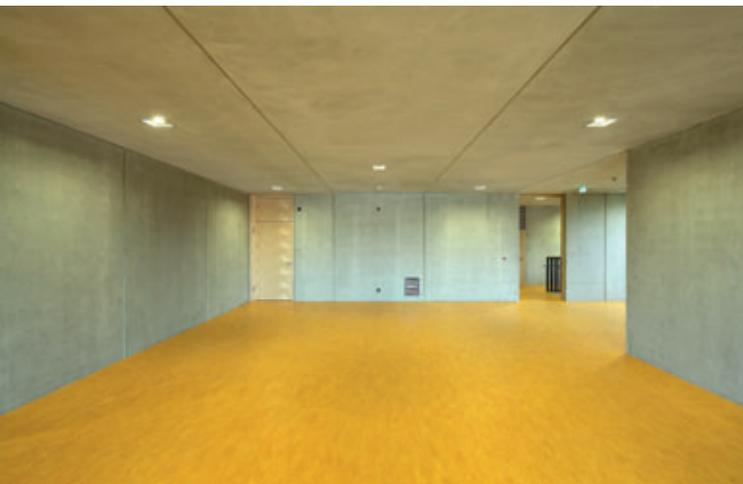
*Sichtbetonoberfläche mit Akzentuierung der Elementfugen*
