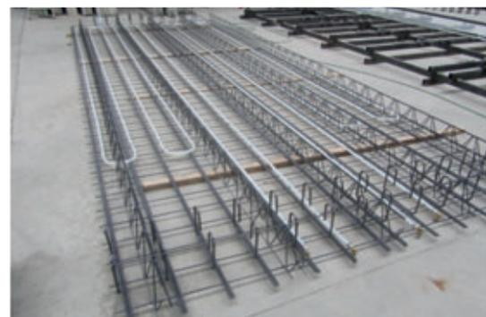
Präzise Herstellung der Rohrregister
