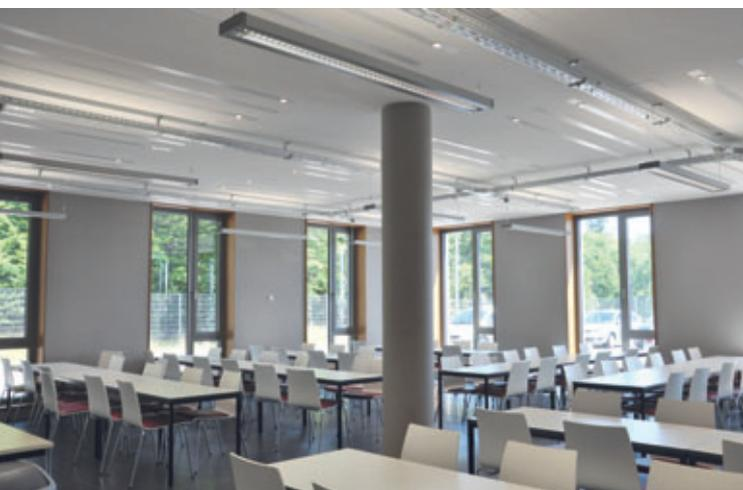
*Deckenoberfläche einer tragenden Betondecke mit der Funktion einer Kühldecke*
