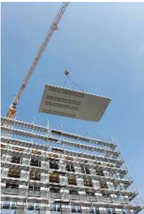
Ceiltec® vorgefertigte, tragende Betonplatten funktionieren auch als große Heiz- und Kühlflächen
