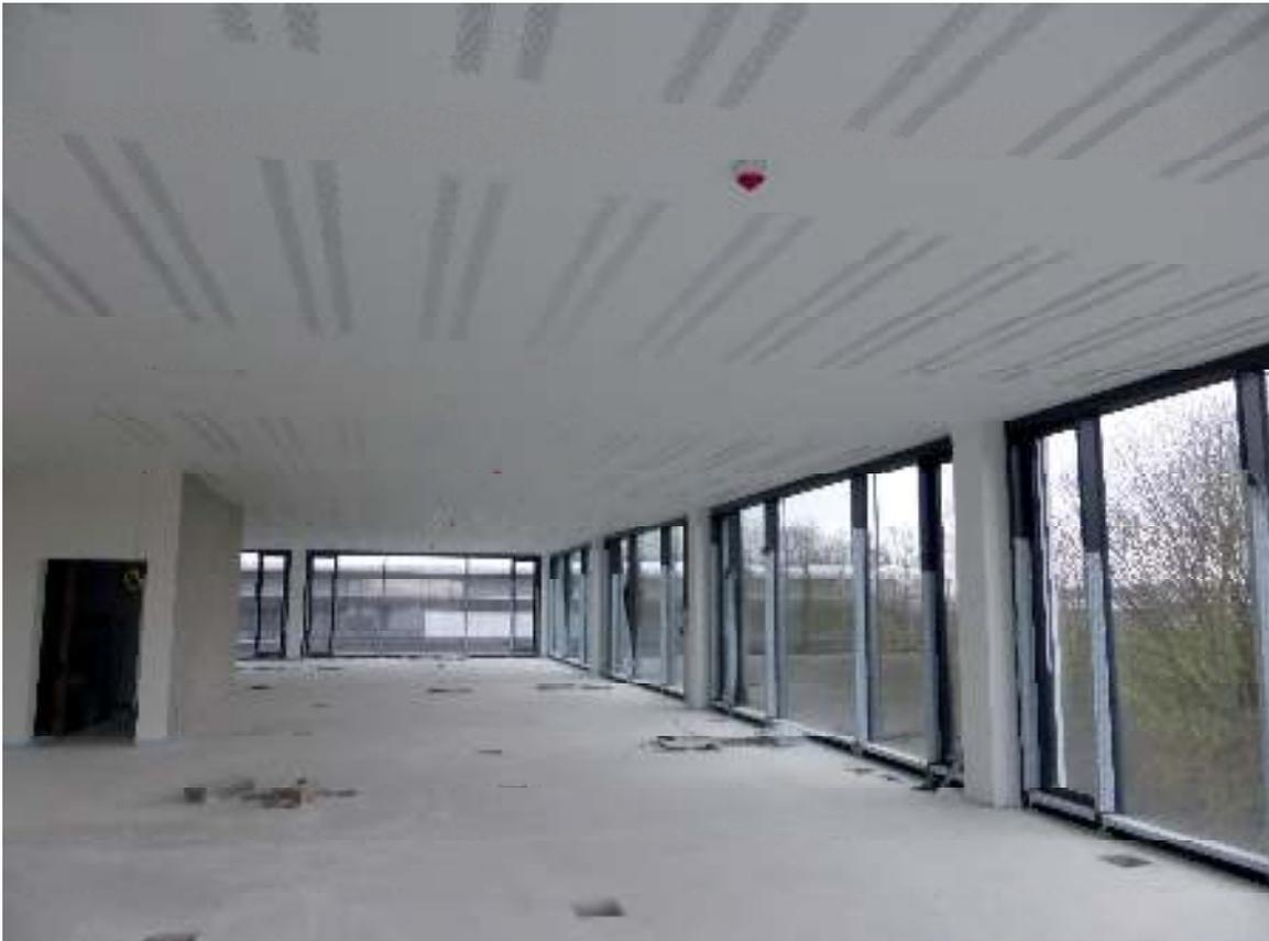
Ceiltec®: die multifunktionale Deckenplatte: Weitgespannte Deckenplatten für flexible Räume, vollständige Klimatisierung über die Decke inklusive effizienter Akustik und Vollglasfassade.
