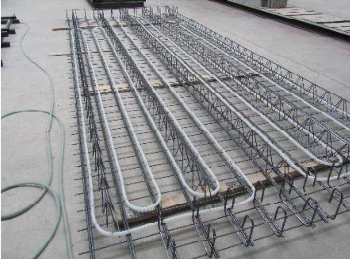
Wasserführende Rohre für den Wärmetransport innerhalb der dünnen Betonschicht des Ceiltec®-Deckenelements mit Sandwichquerschnitt
